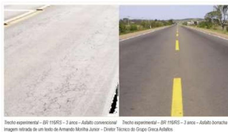
FIGURA 4- Diferença entre o asfalto convencional e o asfalto borracha.
