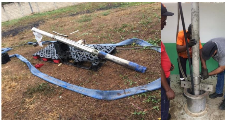
Fig.7 Montagem da boma submersível
