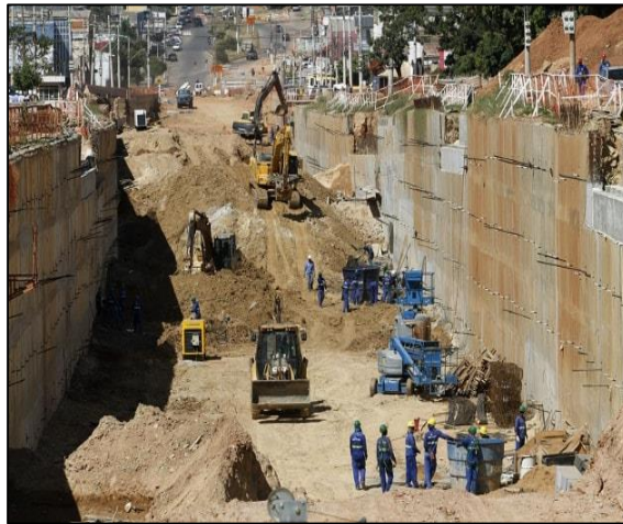
Figura 02 – Canteiro de obras do tipo longos e estreitos Fonte: Pereira (2018, p. 04).
