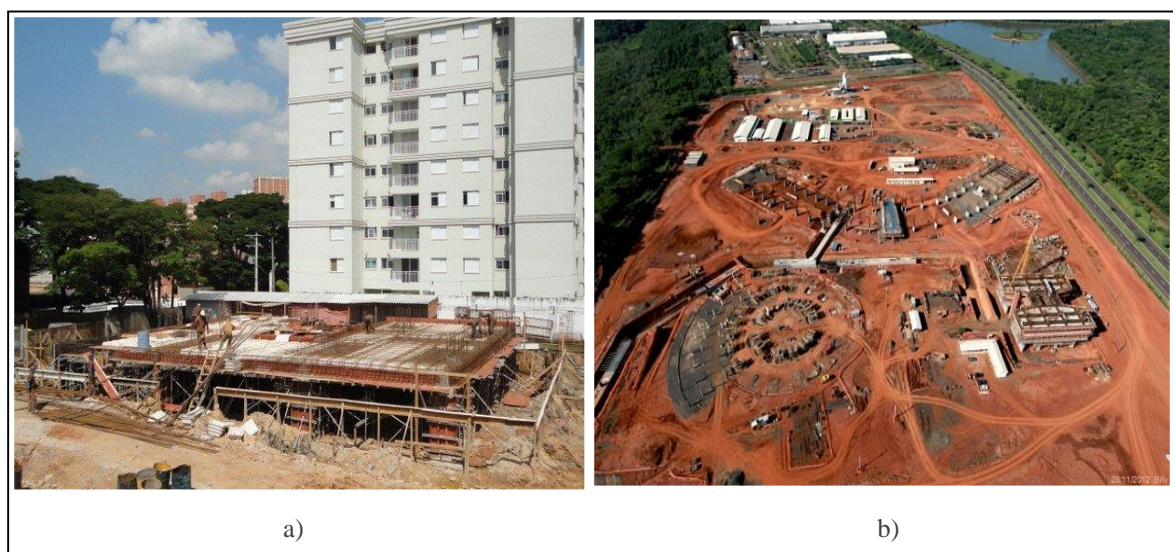
Figura 01 – Canteiro de obras: a) do tipo restritos e b) do tipo amplos Fonte: Pereira (2018, p. 03) / Adaptação realizada pela autora (2019).
