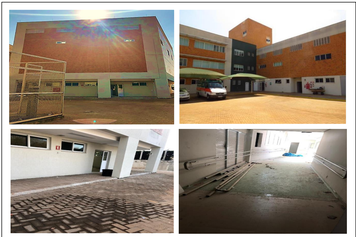
Figura 11 – Área de ampliação em fase de acabamento e conclusão Fonte: Própria autoria (2019).
