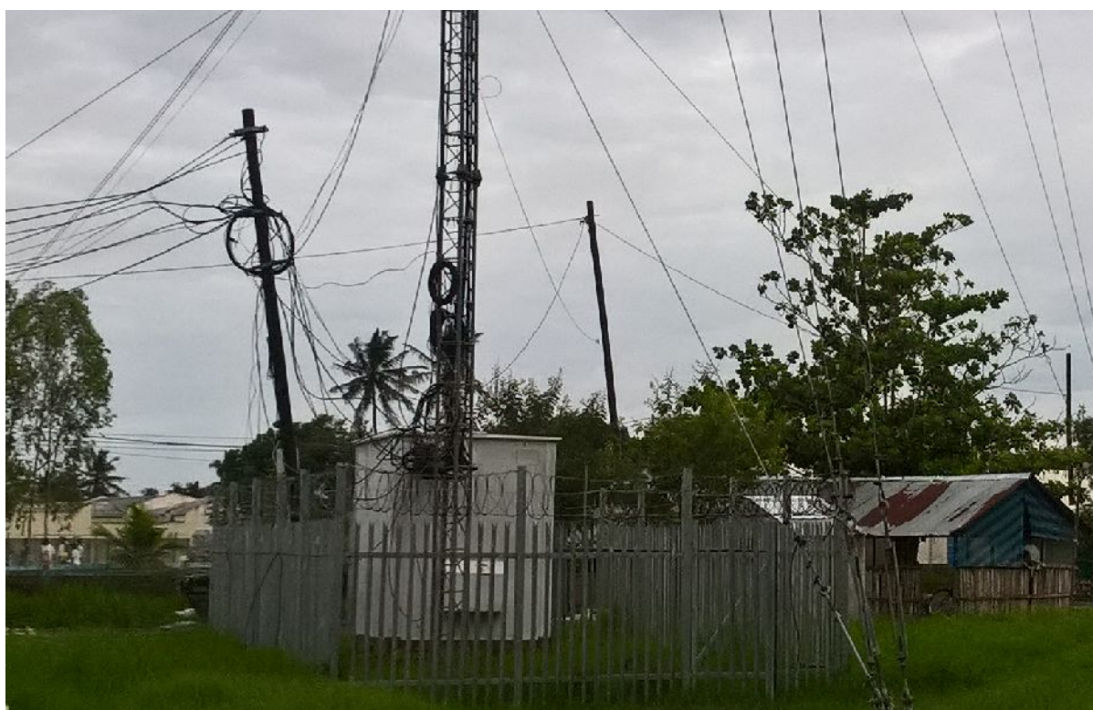
Fig. 4 Condicionantes: Antena de Telefonía móvel e poste de transporte da corrente eléctrica
