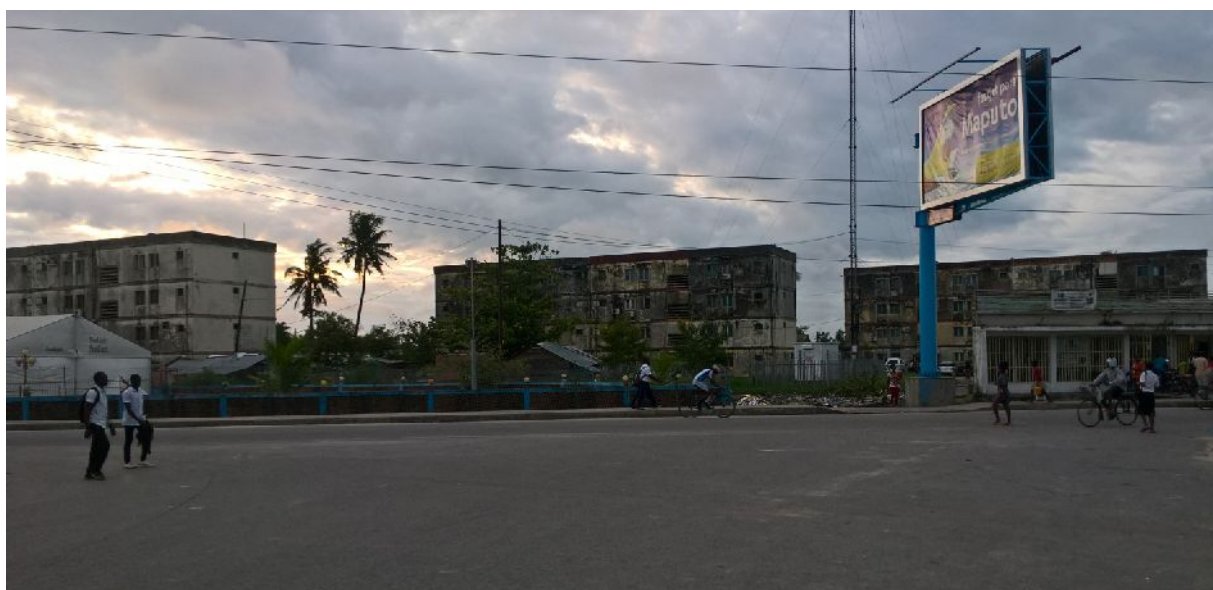
Fig.2 Vista panorâmica dos três prédios
