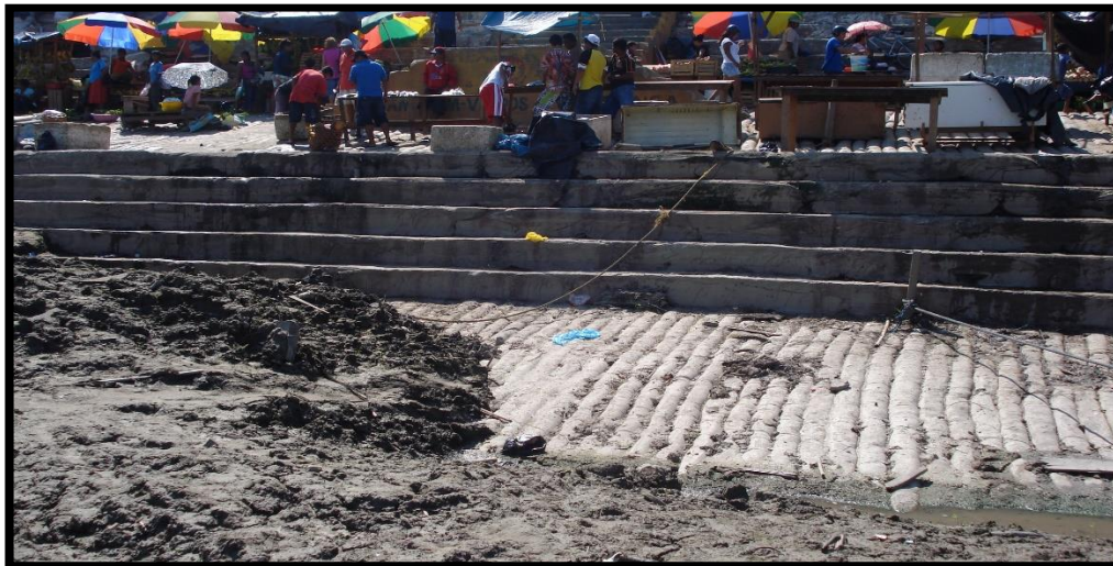
Figura 5: Estrutura do complexo sendo tomada pelo processo de sedimentação.
