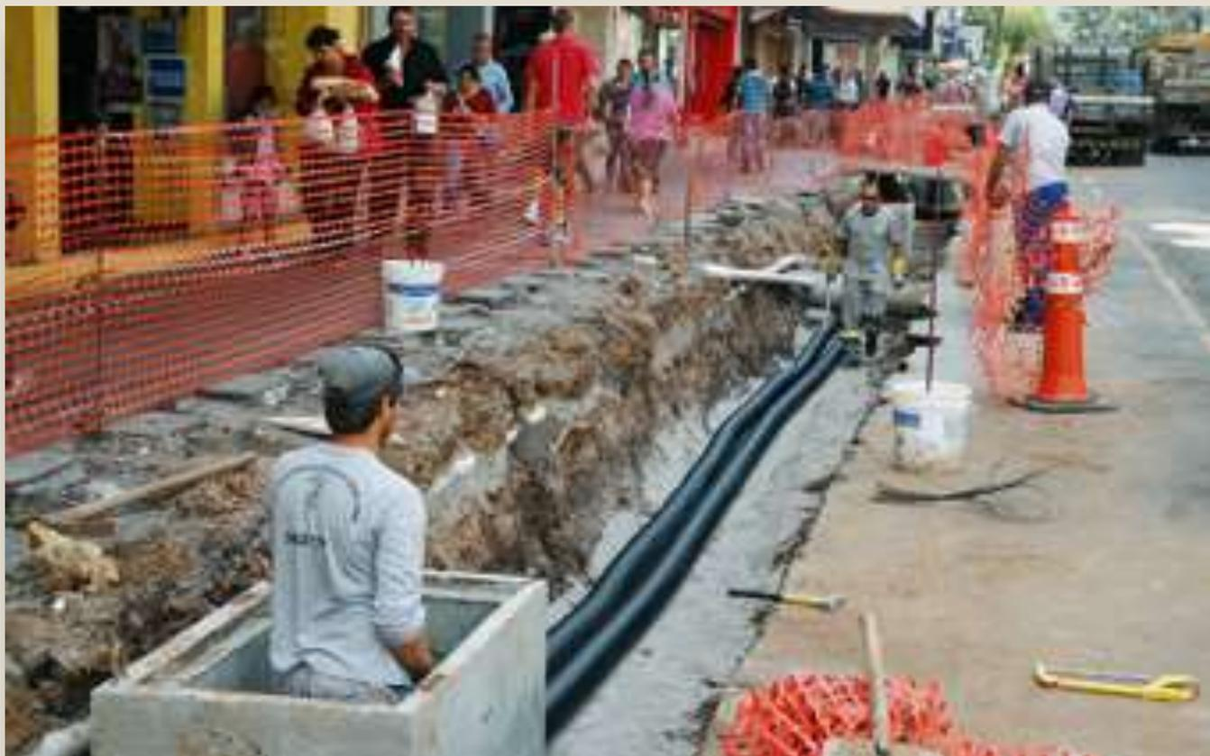
Conforme o manual de Projetos de Redes de Fibras Óticas, é requerido uma caixa subterrânea com espaçamento de 100 a 200 metros nas áreas urbanas e 1000 metros em área rural, as caixas de dutos devem possuir as seguintes medidas: 0,40m x 0,35m e 70mm de profundidade, podendo variar de acordo com as dimensões dos dutos. Não é comum utilizar nas construções de dutos para fibras, conexões como: ( T, niple e cotovelo).
