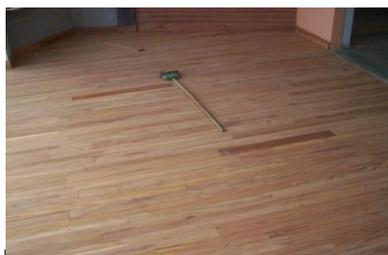
Foto 3: residência lagoinha 2008-reforma Impacto Arquitetura. Reaproveitamento de sobras de madeira do telhado (reforma) para deck de marchetaria (retalhos de
