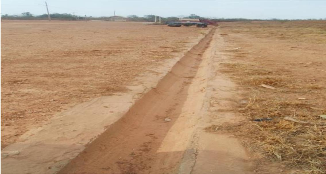
**Figura 02:**Drenagem pluvial do aterro sanitário de Janaúba.
