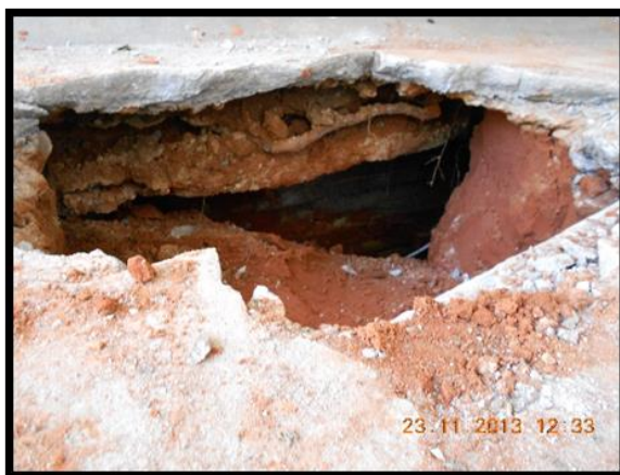
Figura 29 e Figura 30: Buraco na rampa do edifício belver. (Fonte : O Autor)
