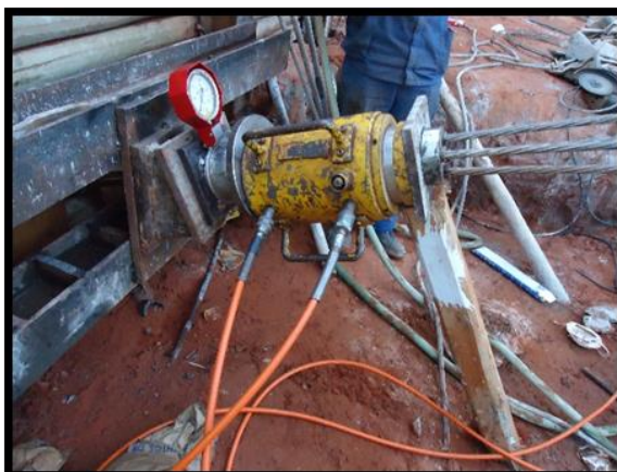
Figura 14: - Aplicação da tensão com auxílio do macaco hidráulico (Fonte: o Autor)
