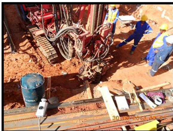
Figura 8: Furação vertical “h=11,1m” (Fonte: O autor)
