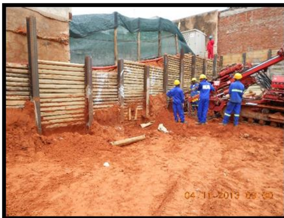
Figura 12: - Furação para colocação de ancoragens (Fonte: O autor)
