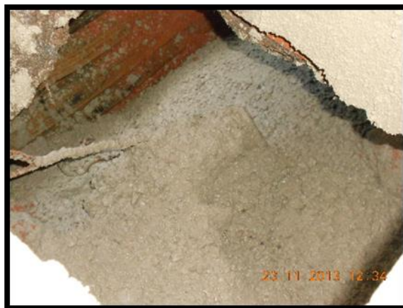
Figura 32: Colocação de betão. (Fonte: O Autor)
