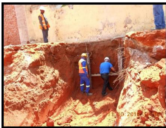
Figura 10: - Colocação de pranchões de madeira (Fonte: O autor)
