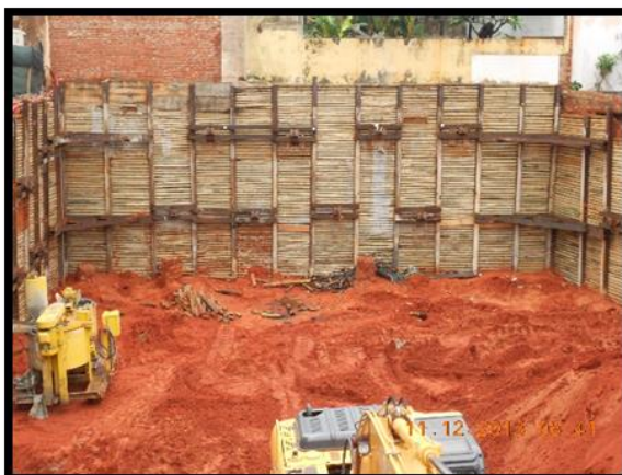
Figura 19: - Nível inferior de escavação (Fonte: o Autor)
