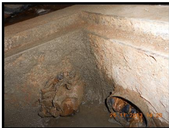
Figura 34: Caixa de visita reparada. (Fonte: O Autor)
