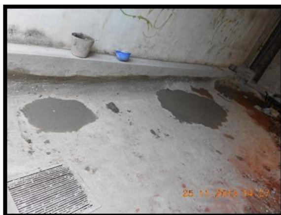
Figura 33: Colocação de betão. (Fonte: O Autor)
