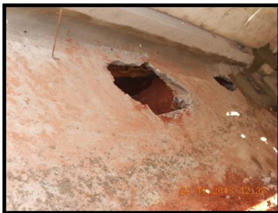
Figura 29 e Figura 30: Buraco na rampa do edifício belver. (Fonte : O Autor)
