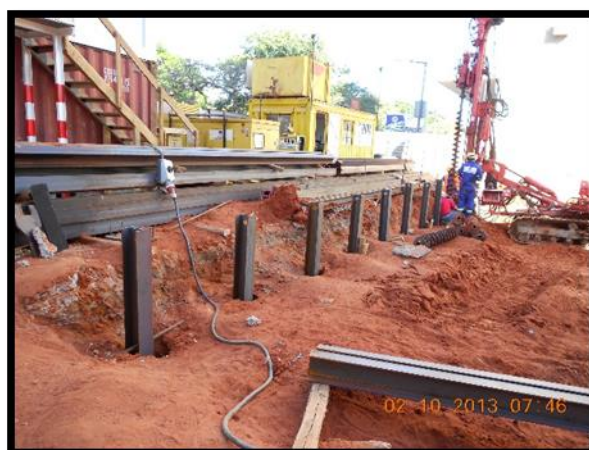
Figura 9: Perfil HEB enterrado 0,9m do seu comprimento total 12 metros (Fonte: O autor)
