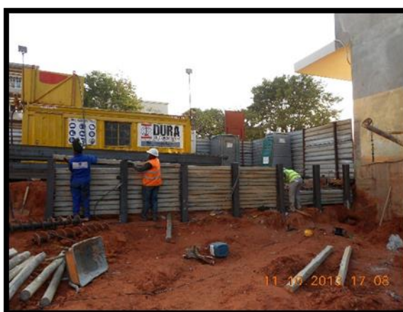
Figura 11: Colocação de pranchões de madeira (Fonte: O autor)
