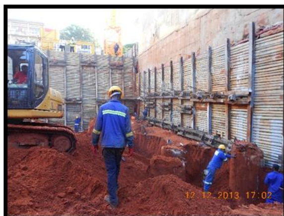
Figura 18: - Nível inferior de escavação (Fonte: o Autor)
