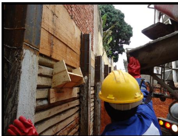
Figura 26: Colocação de bico de pato e betão. (Fonte: o autor)
