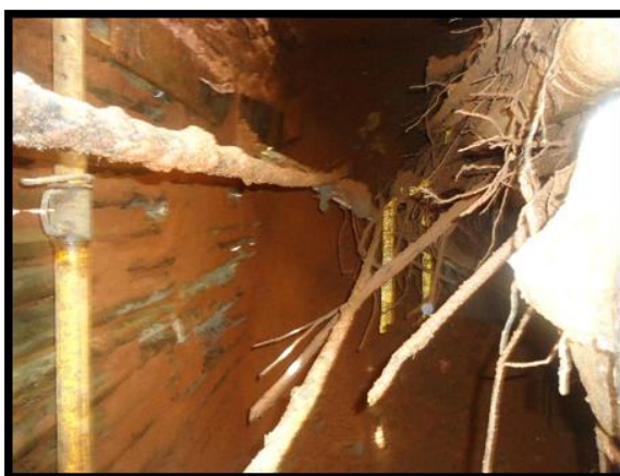
Figura 38: Suporte do passeio com prumos aquando a realização dos trabalhos. (Fonte: o Autor)
