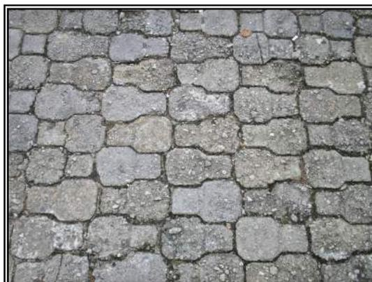
**Figura 45 – Blocos de concreto intertravados/ estacionamento.**
