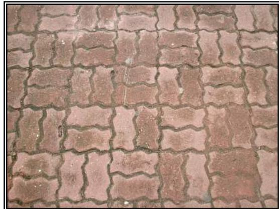
**Figura 49 – Bloco de concreto intertravado.**
