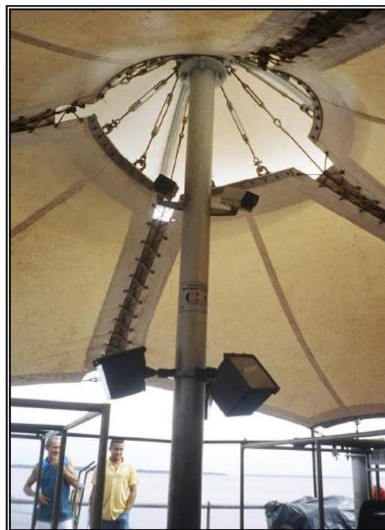
**Figura 116 – Pilares centrais / tensionamento.**
