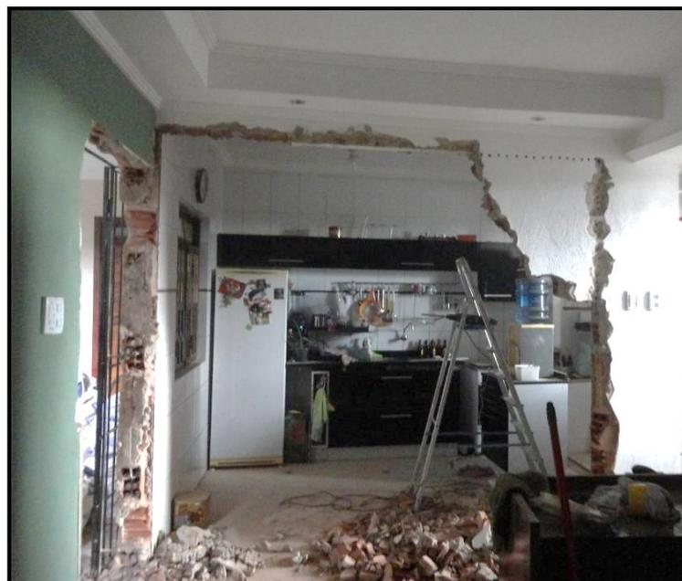
**Figura 17** - Ao lado direito, isolou-se com gesso o antigo vão onde era a passagem para a cozinha
