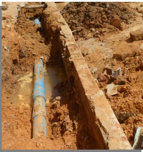
Figura 21 – Tubulação em cimento - amianto
