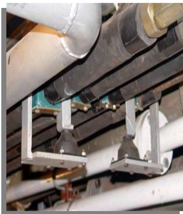
Figura 32 – Tubulação usando folha elastomérica
