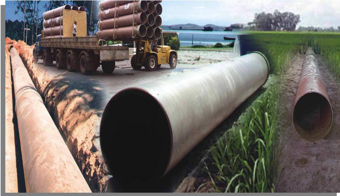
Figura 63 – Tubos revestidos com material poliéster
