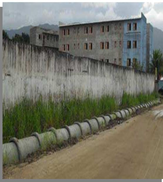
Figura 23 – Sistema de transporte de água pluvial
