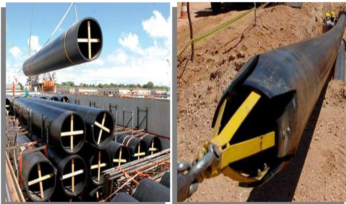
Figura 42 e 43 – PEAD utilizado em sistemas de saneamento básico, drenagem, mineração, infra-estrutura
