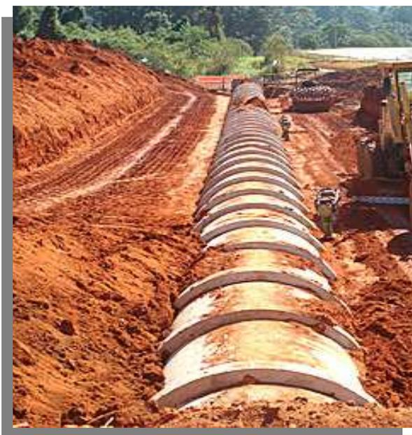
Figura 22 – Sistemas de tubulação em fase de acabamento
