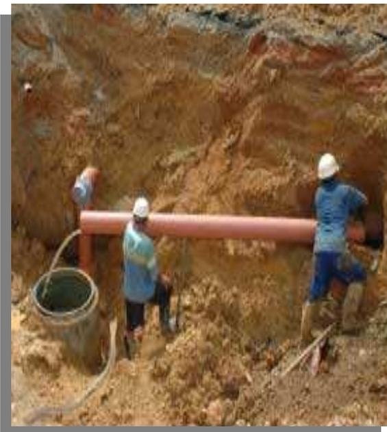
Figura 49 – PVC sendo utilizado em rede coletora de esgoto
