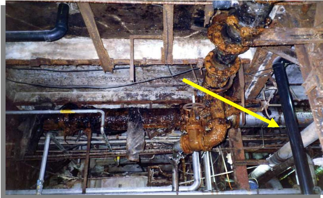
Figura 54 – Tubulação em ABS em uma fábrica de papel
