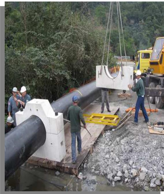
Figura 44 – Montagem de PEAD subaquático
