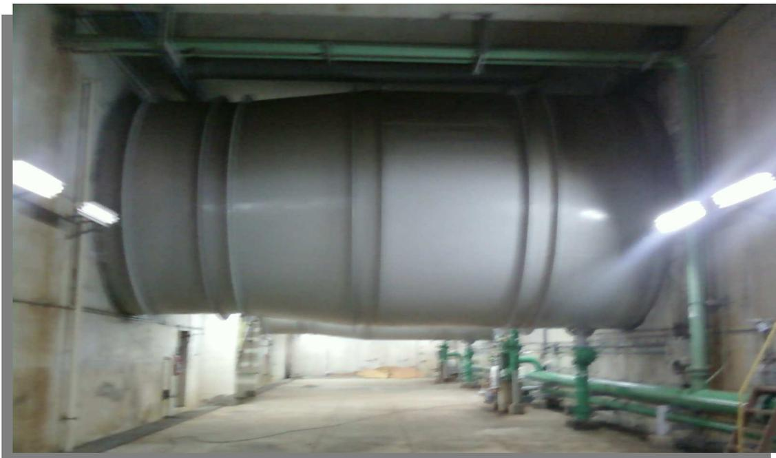
Figura 9 – Tubo funcionando como conduto forçado
