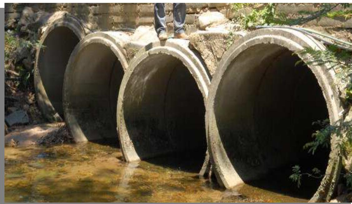
Figura 10 – Tubo de esgoto funcionando com superfície livre
