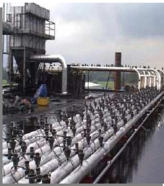
Figura 50 – PVC sendo utilizado no transporte pneumático de matéria prima para a fabricação de borracha
