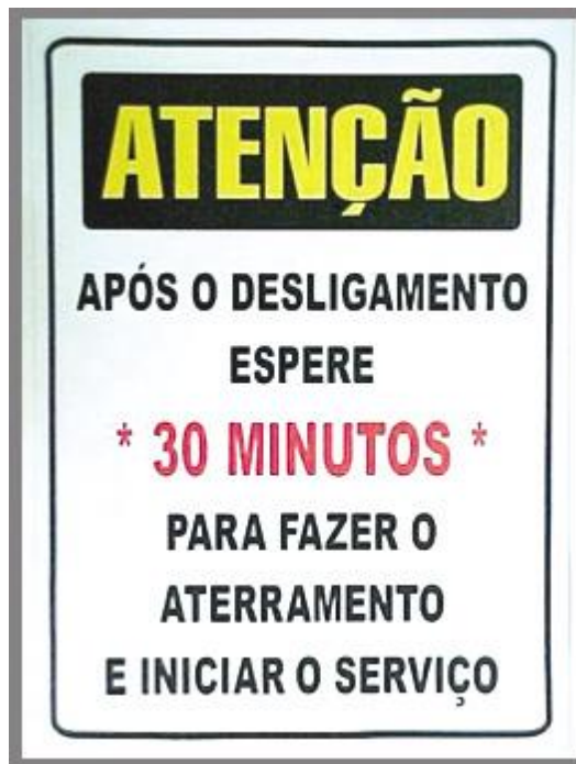
Figura 30: Placa atenção para banco de capacitores e cabos a óleo.
