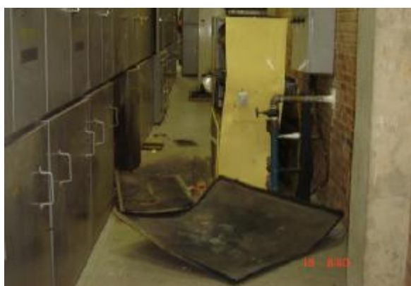
Figura 34: Tampas do painel arremessadas
